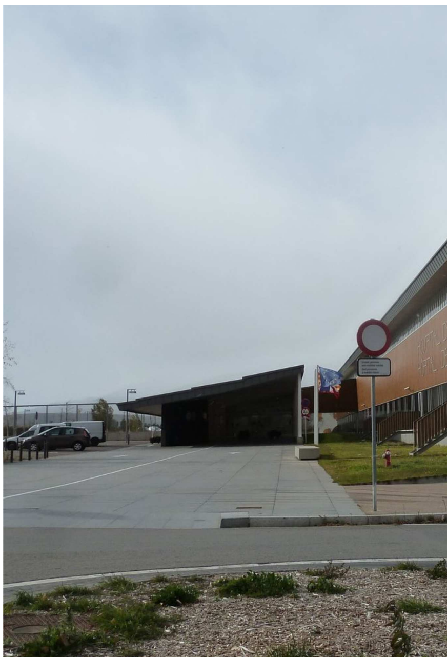
L'hospital de Cerdanya, a la fotografia una vista general de l'accés principal
