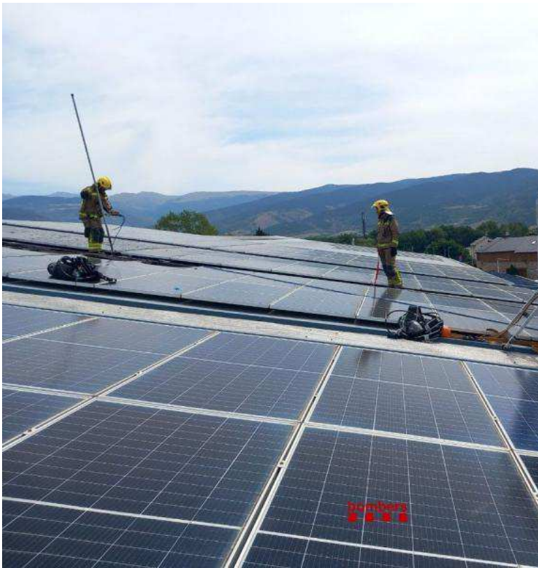
Els bombers, treballant en la teulada afectada CEDIDA .
