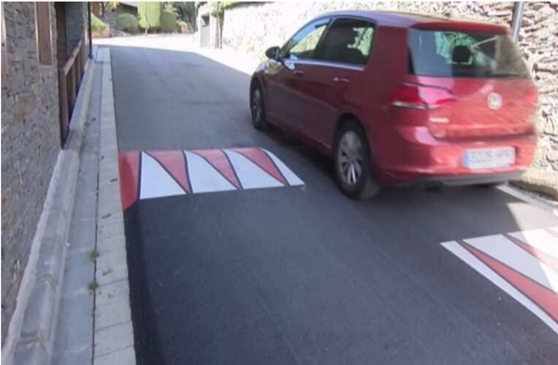
Un dels reductors instal·lats en alguns dels carrers de Bolvir./M.F.
