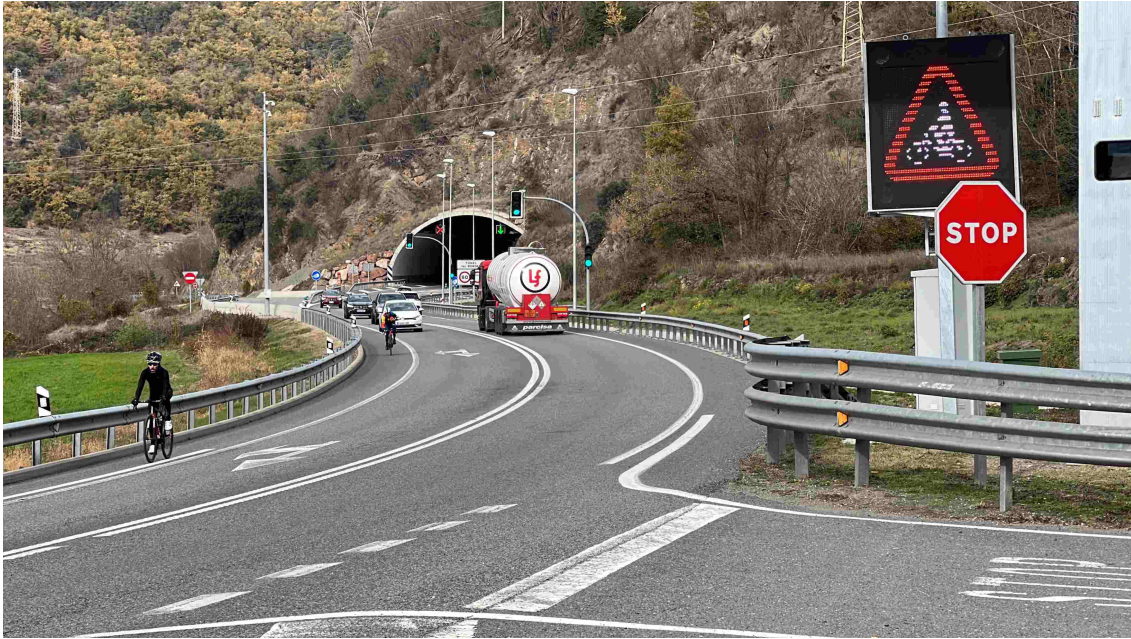
Carretera N-145, al terme municipal de Valls del Valira / Albert Lijarcio
