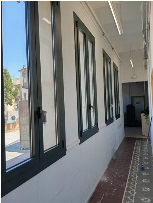
Finestres noves instal·lades en els treballs de millora CEDIDA.
