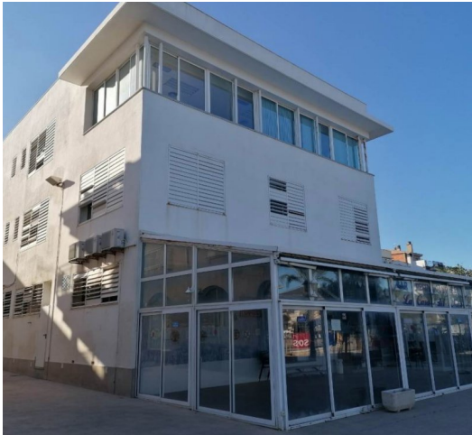
L'edifici de la Casa del Mar de Llançà, en una imatge d'arxiu AJ. LLANÇÀ.
