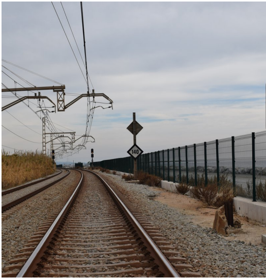
Tanques al costat de la via ADIF.
