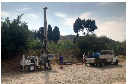
La màquina perforadora per obrir el nou pou CEDIDA A L'ACN.
