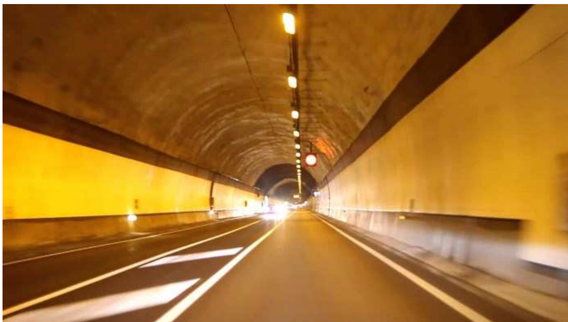
Interior del Túnel del Cadí
