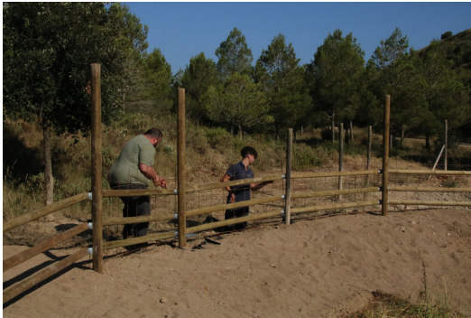
Dues persones instal·lant una malla al voltant de la tanca per evitar que entrin els senglars. acn.
