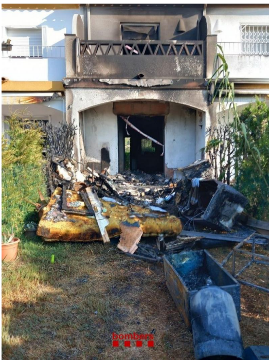
Façana de l'habitatge que s'ha cremat a Torroella de Montgrí aquest matí BOMBERS.
