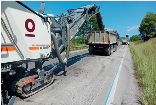
Comencen les obres del ferm a la C-152 entre Santa Coloma de Farners i el trencant de l'Eix Transversal EPA.
