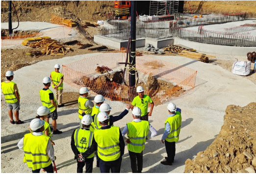
Les obres d'ampliació de la depuradora de Sant Gregori. cedida.
