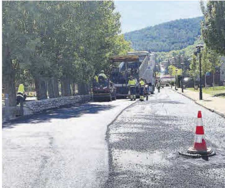
Les obres de millora de l'Avinguda Mancomunitat davant de l'escola
