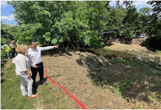
Visita d'obres que s'estan fent a Amer. ACA.
