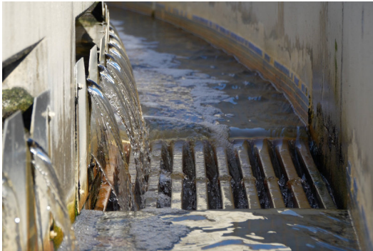
La depuradora de Lloret de Mar. AJUNTAMENT DE LLORET DE MAR.
