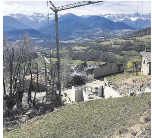
Una casa de segona residència en construcció a la Cerdanya
