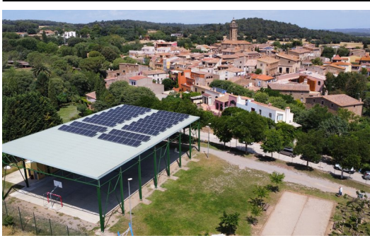
La instal·lació fotovoltaica de Rupjà, que ja dona servei als veïns AJ. RUPJÀ.
