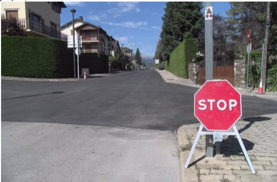
Un dels carrers d'Alp on s'està millorant la pavimentació./M.F.
