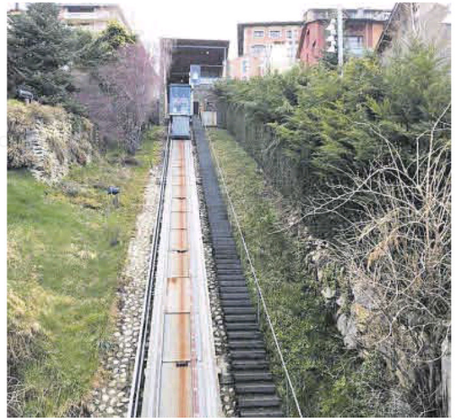
L'ascensor inclinat que dona accés a la plaça de l'Ajuntament
