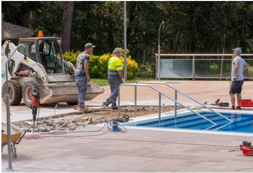
Els operaris, canviant el paviment al voltant de la piscina ICONNA / AJUNTAMENT DE RIUDELLOTS DE LA SELVA.
