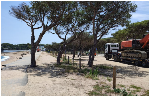
El desplegament de maquinària, ahir al migdia, a la zona de la platja de Riuet de Platja d'Aro, que reforçaran amb rocalla E.A.
