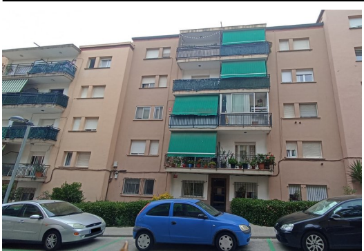
Un dels edificis construït a la dècada dels 70 i ubicat al barri de Mas Guàrdies. AJUNTAMENT DE PALAMÓS.
