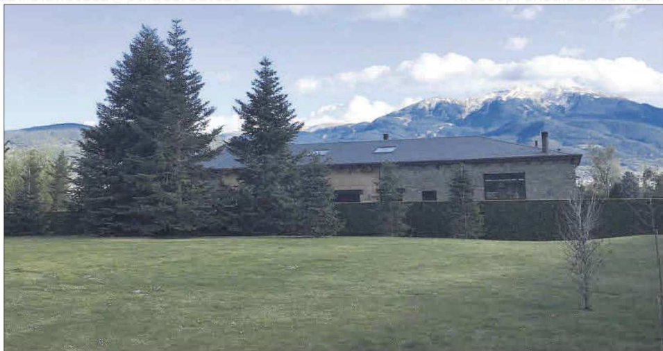
La casa que Isidre Chia i la seva parella s'han construït a la urbanització la Corona i que uns veïns han denunciat
