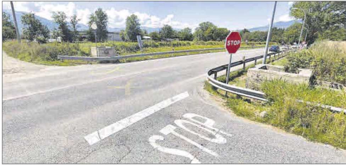
La zona on va tenir lloc l'accident, al quilòmetre 180 de l'N-260, a Puigcerdà
