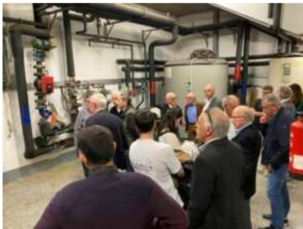
La sala de la caldera de biomassa durant la visita. / J.F.D.
