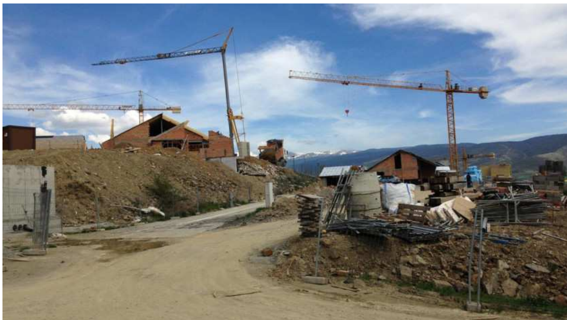
La construcció creix a la Cerdanya
