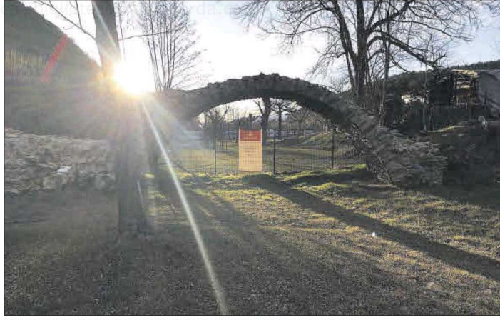
El Pont del Diable restaurat sobre la terrassa a la ribera del Segre, també neta
