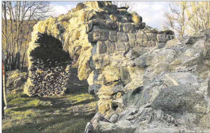
Una de les bases del pont que ha evidenciat tenir un origen romà
