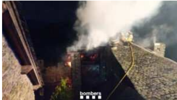
Bombers extingint el foc al teulat de la casa de Surp. / BOMBERS DE LA GENERALITAT
