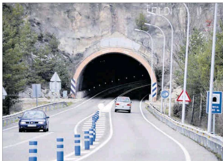
Un dels túnels actuals de la C-16, a Cercs
