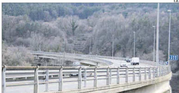
UN NOU VIADUCTE A CERCS ▶ És una de les grans obres a fer. Serà més llarg que l'actual i més separat del nucli de Cercs. L'actual s'enderrocarà quan entri en servei el nou.
