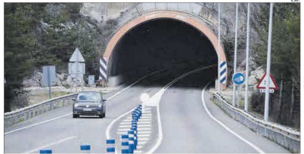
CINC TÚNELS NOUS, DESDOBLATS ▶ El projecte preveu cinc perforacions a la vora dels túnels actuals. Una de les perforacions és de 850 metres. Tindran dos carrils.
