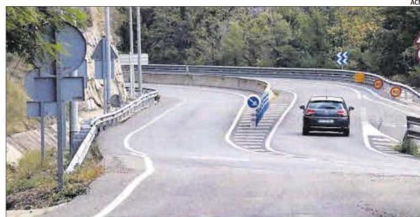
CARRETERA SINUOSA I CARA ▶ La inversió de 240 milions s'explica per la necessitat de resoldre molts punts conflictius d'un traçat sinuós que passa encaixonat entre muntanyes.
