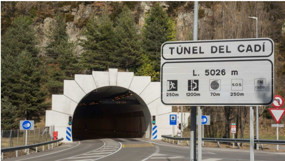
Túnel del Cadí
