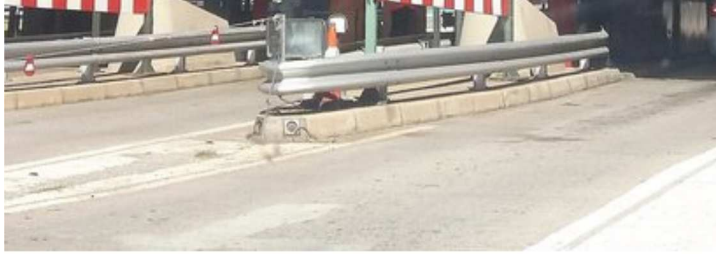
El peatge del túnel del Cadí en sentit nord J
