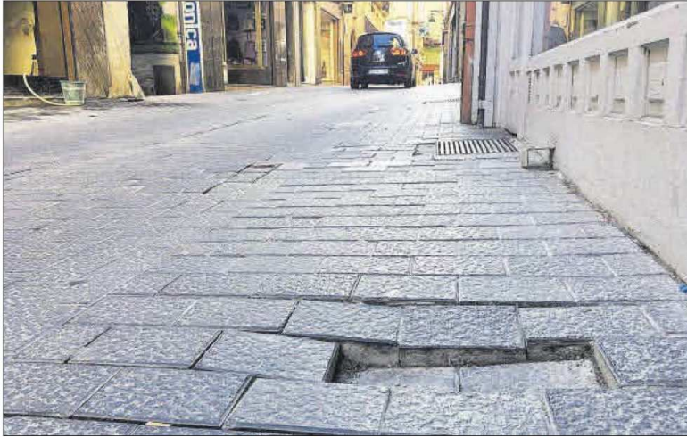
A l'esquerra, un forat causat per l'esfondrament de les rajoles a l'illa de vianants. A la dreta, un graó trencat a les escales d'accés al nucli antic
