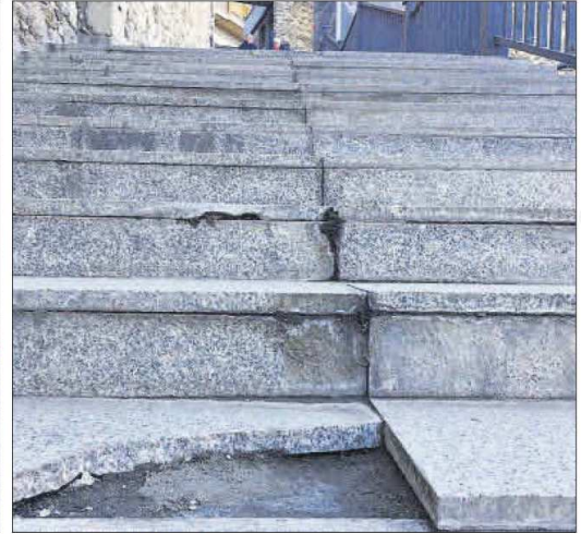
A l'esquerra, un forat causat per l'esfondrament de les rajoles a l'illa de vianants. A la dreta, un graó trencat a les escales d'accés al nucli antic
