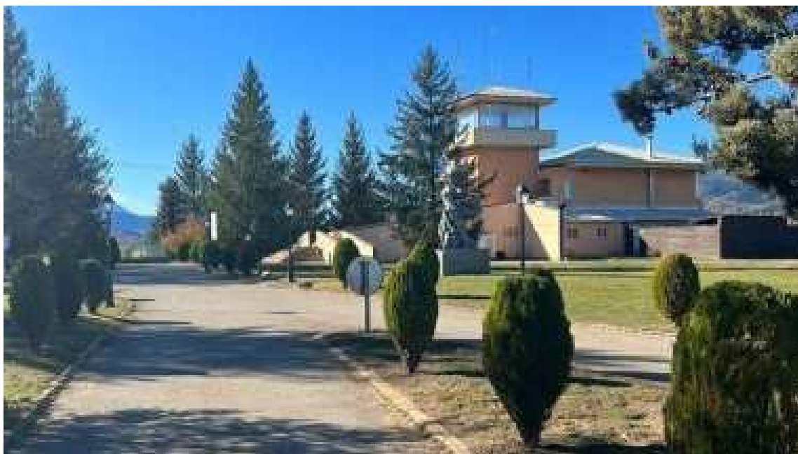
Aeròdrom de Cerdanya | Aeroports de Catalunya
