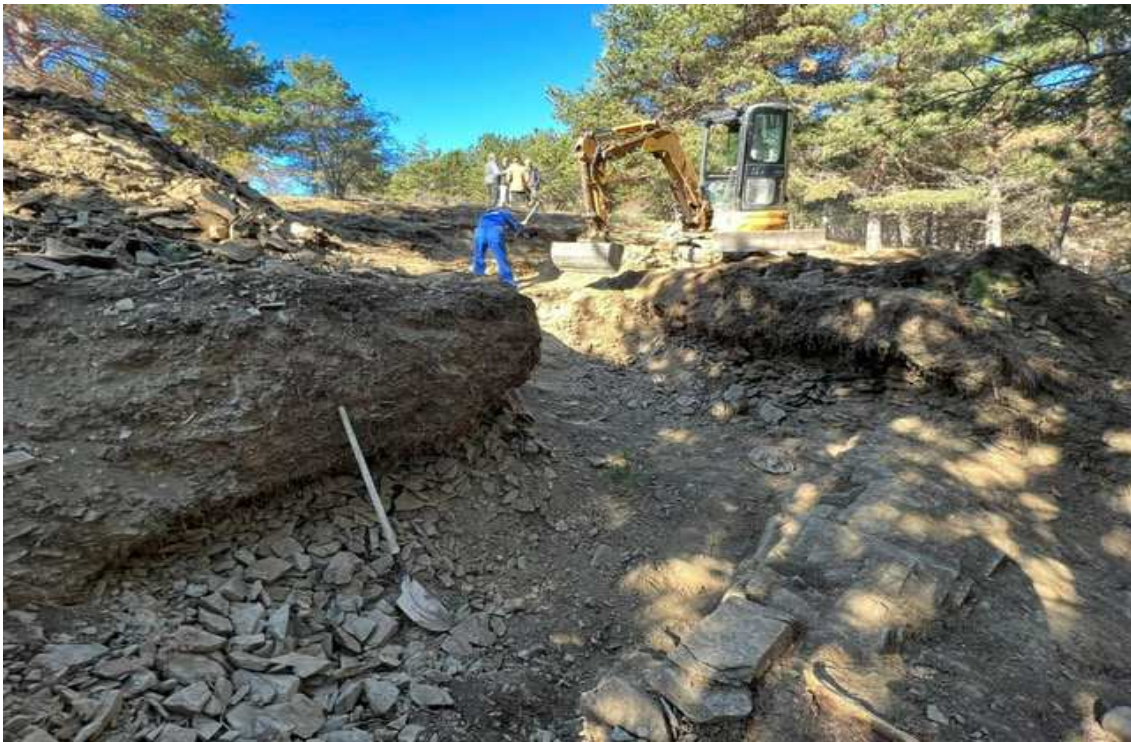
Excavacions al castell de Llivia. / M.F.C.
