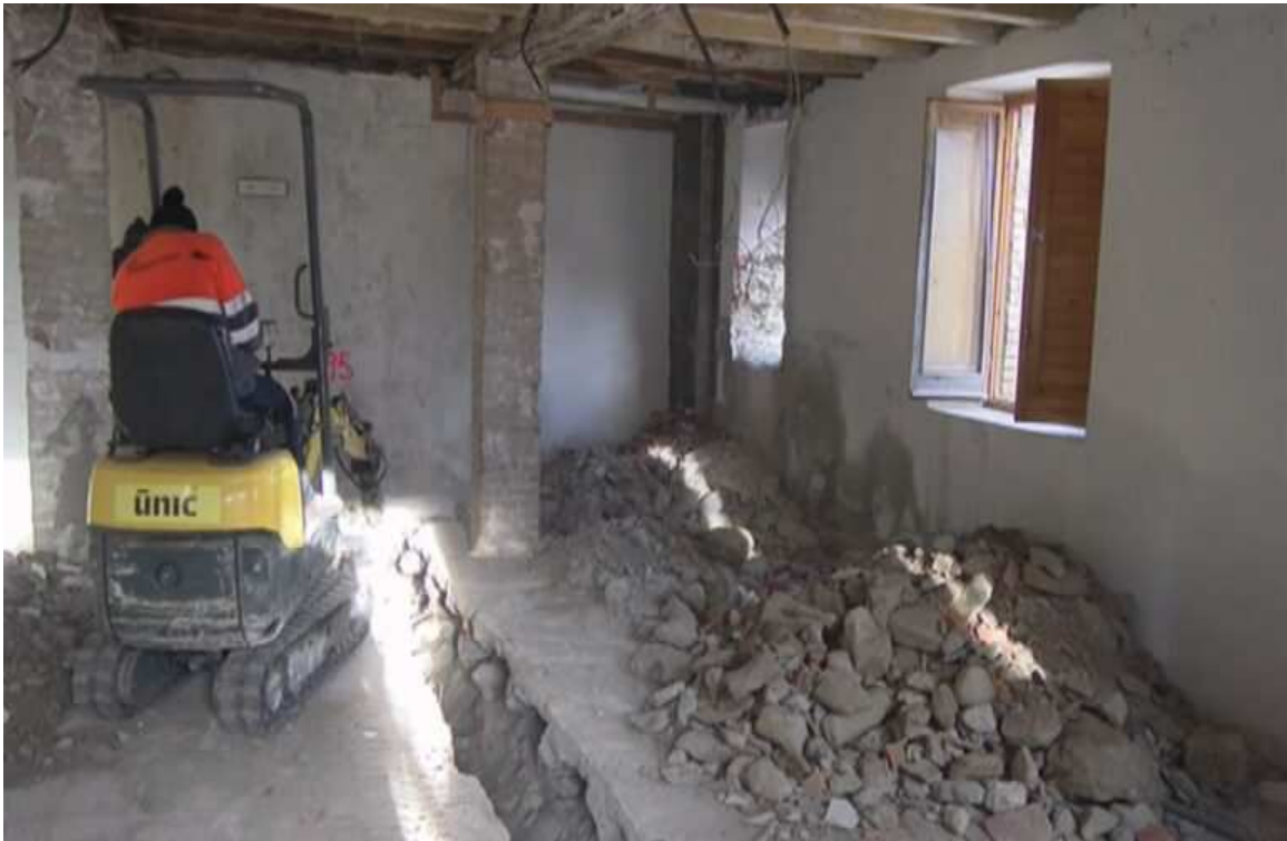
Obres a l'interior de l'edifici del futur bar-botiga de Queixans. / M.F.C.
