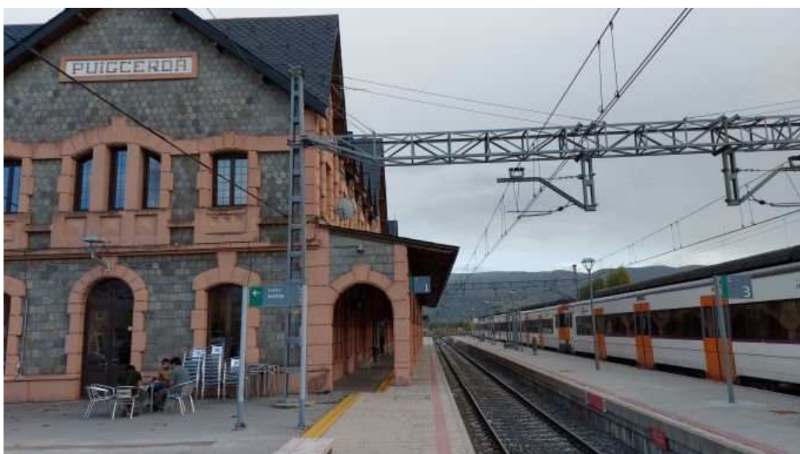
photo_camera L'estació ferroviària de Puigcerdà dona servei a la vila de Puigcerdà i a la Baixa Cerdanya / Feliu Sirvent
