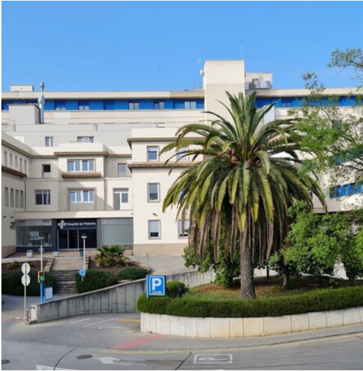
Façana de l'hospital de Palamós SSIBE.
