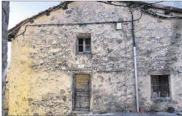
Un dels habitatges de Travesseres que es rehabilitarà
