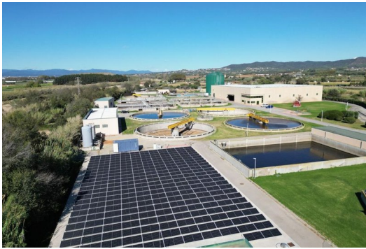
Imatge elevada de les plaques, en primer terme. CEDIDA.
