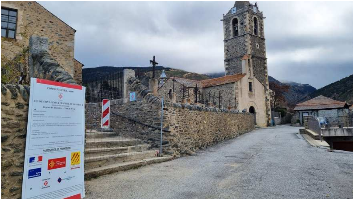
Les travaux se poursuivent pour le programme de réhabilitation des édifices religieux.
