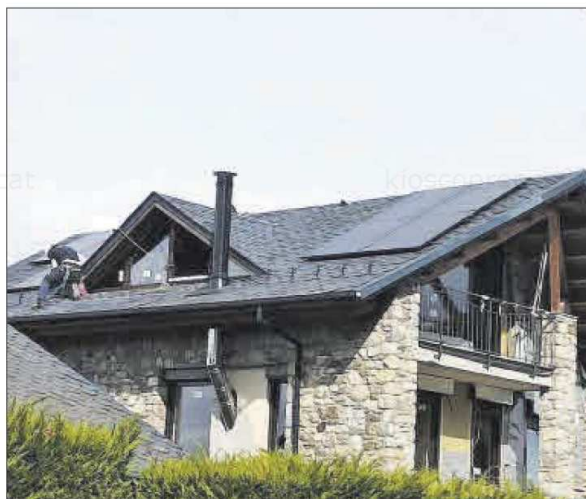
Un operari instal·la plaques fotovoltaïques
