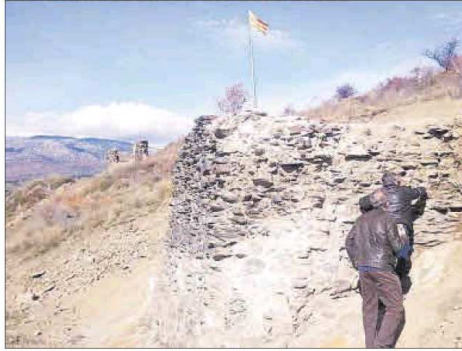
Tècnics arqueòlegs inspeccionen la muralla del castell
