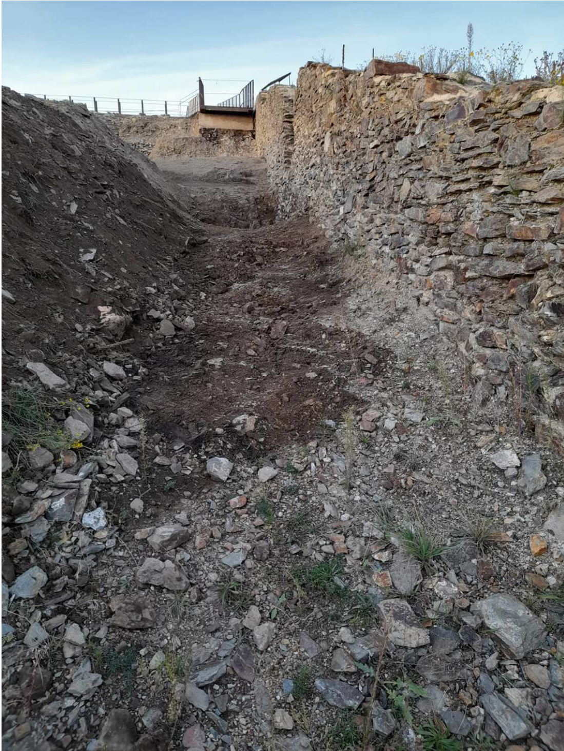
Comença una nova fase d'excavacions i de consolidació al castell de Llivia / llivia.org
