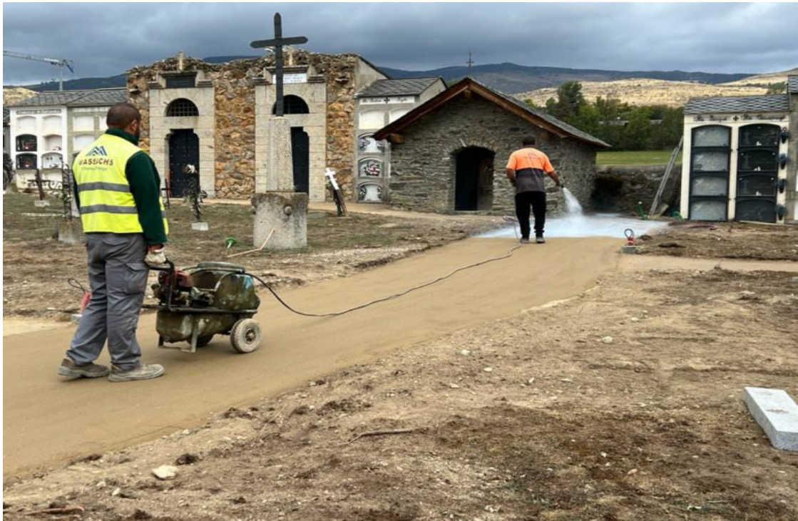
Obres de millora al cementiri de Ger. / M.F.C.
