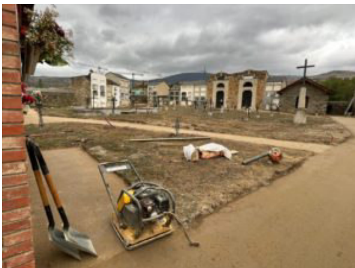
Obres de millora al cementiri de Ger. / M.F.C.
