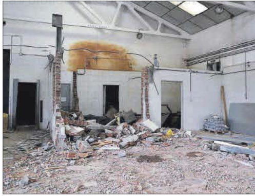
L'interior de l'antic escorxador, que s'està rehabilitant
