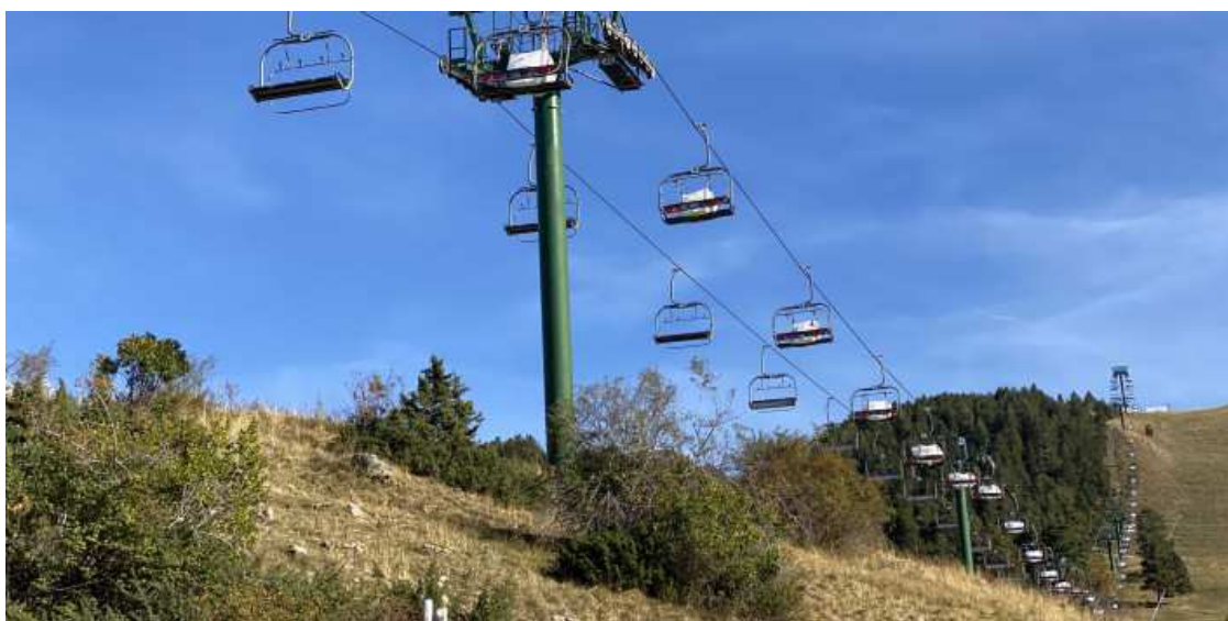
Proves de càrrega als telecadires Trampolí i Font Canaleta de La Molina Autor/a: Diaridelaneu
