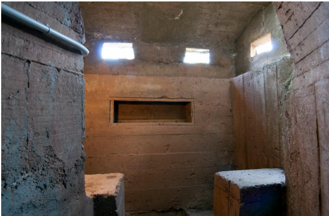
Interior d'un búnquer. / PARC DELS BÚNQUERS
