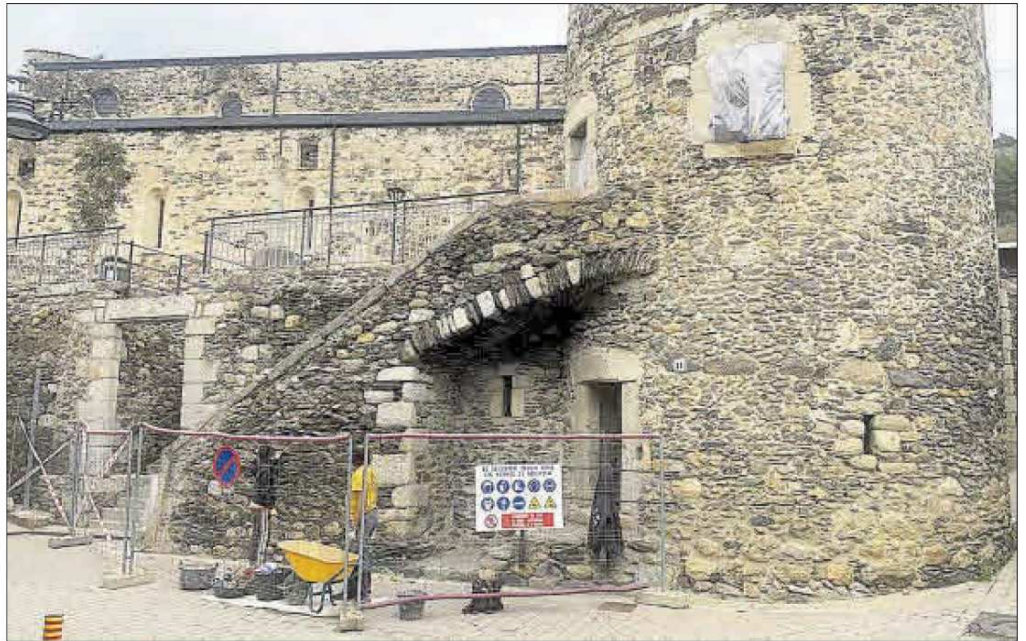
Les obres que ja es porten a terme a la torre Bernat de So
